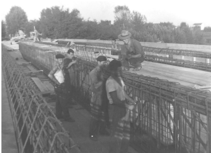
Figura 4: Costruzione del ponte Secula - disposizione armature travate principali (1959)
