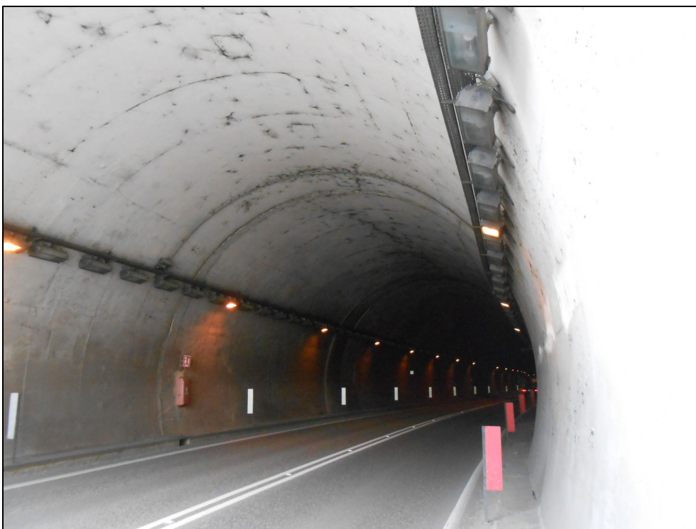
Foto imbocco lato Sud con la posizione degli apparecchi illuminanti esistenti
