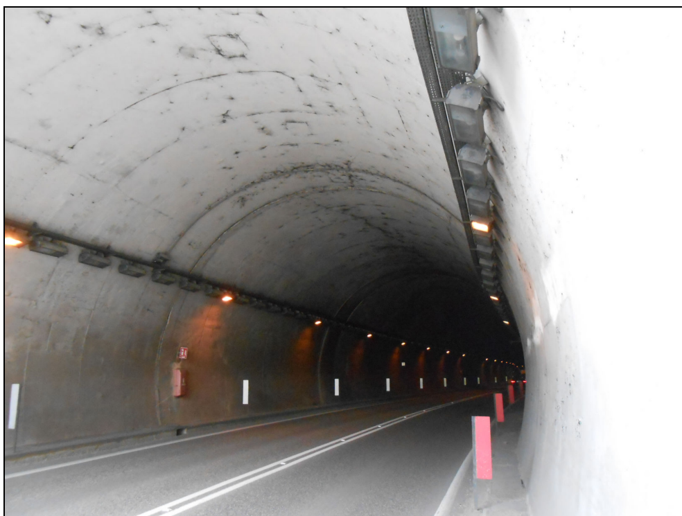
Foto imbocco lato Sud con la posizione degli apparecchi illuminanti esistenti
