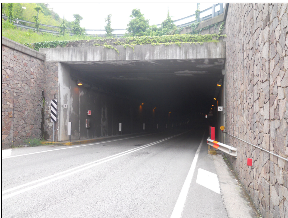
Foto imbocco lato Nord con la posizione degli apparecchi illuminanti esistenti
