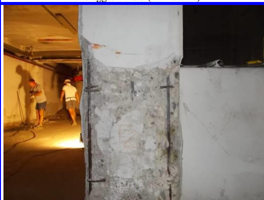
Prelievo di barra d'armatura
