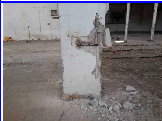
Prelievo di barra d'armatura
