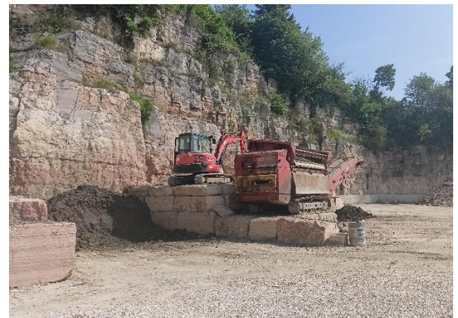
FOTO 4 - Parete rocciosa sul lato nord dell'impianto e in particolare della zona di lavorazione con vaglio sgrossatore
