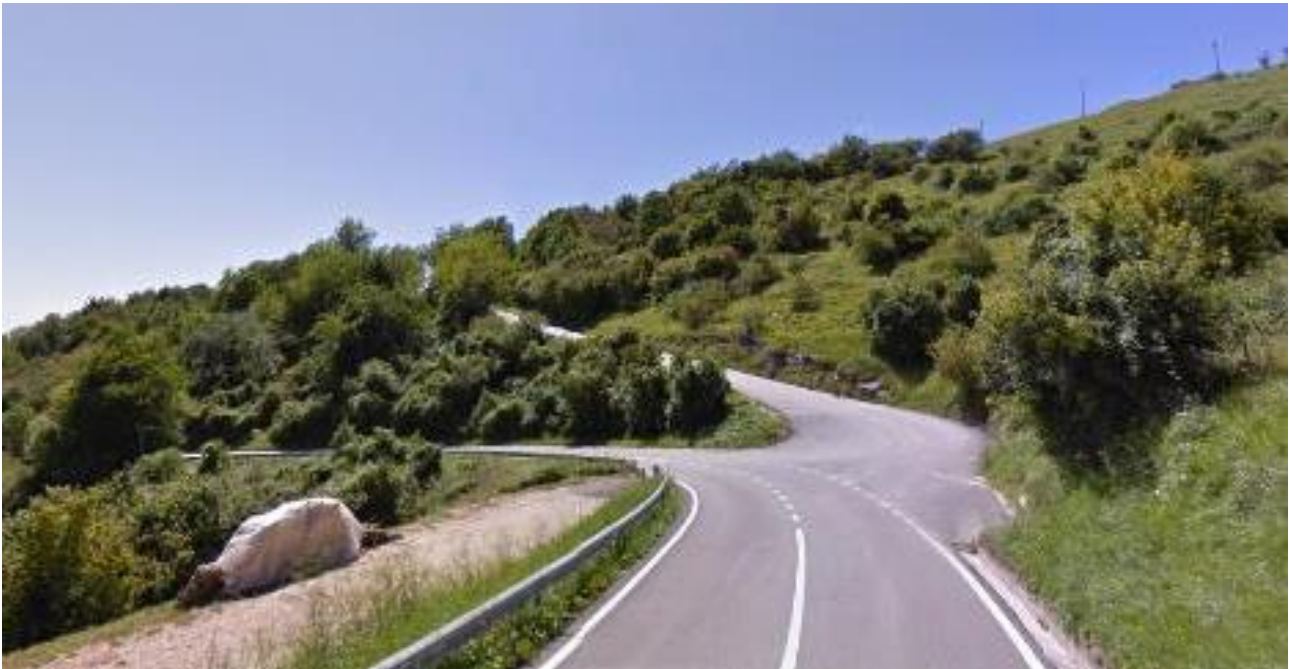
Figura 21 - Ingresso alla strada di pertinenza dell'impianto provenendo da Rubbio
