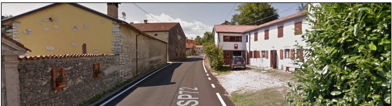
Figura 1.14 – Contra' Tortima (S.P. 72 "Strada della Fratellanza"), direzione nord, verso il centro abitato della frazione Fontanelle di Lusiana Conco (VI)
