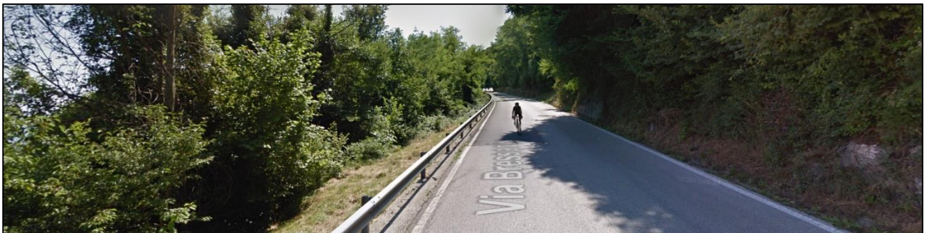
Figura 1.12 – Via Bressani (S.P. 72 “ Strada della Fratellanza ”), direzione nord-ovest, verso Tortima di Lusiana Conco (VI)
