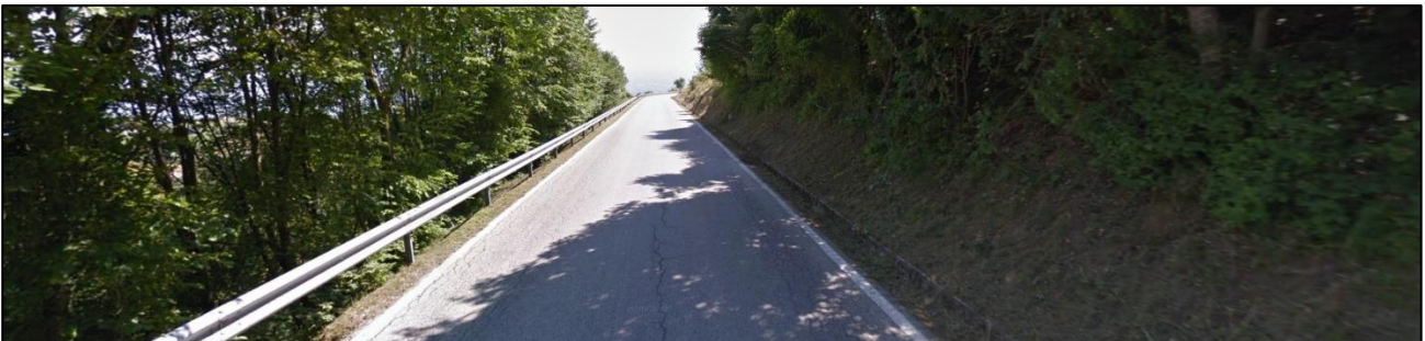
Figura 1.11 – Strada della Scaletta, direzione sud-ovest, verso la S.P. 72 “Strada della Fratellanza” (via Bressani / Contra' Tortima)
