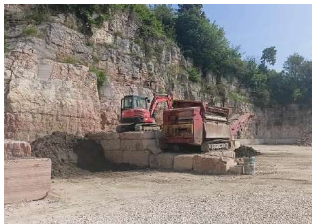
FOTO 4 – Parete rocciosa sul lato nord dell'impianto e in particolare della zona di lavorazione con vaglio grossatore
