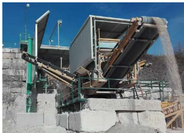
FOTO 2 – Schermatura antirumore sul lato ovest e superiore alla zona di selezione granulometrica
