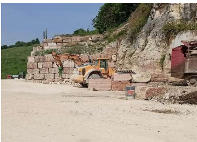
FOTO 3 – Barriera in massi e parete rocciosa sui fronti ovest e nord della zona di lavorazione con martellone
