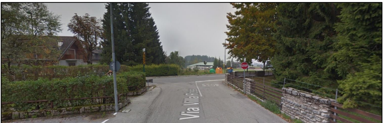
Figura 2.13 – Vista frontale dell'intersezione a raso di tipologia a "T" tra via Villa Rossi e la S.P. 76 "Valgadena" (via Rendola), direzione sud, estremità meridionale (Fonte: Google Street View)
