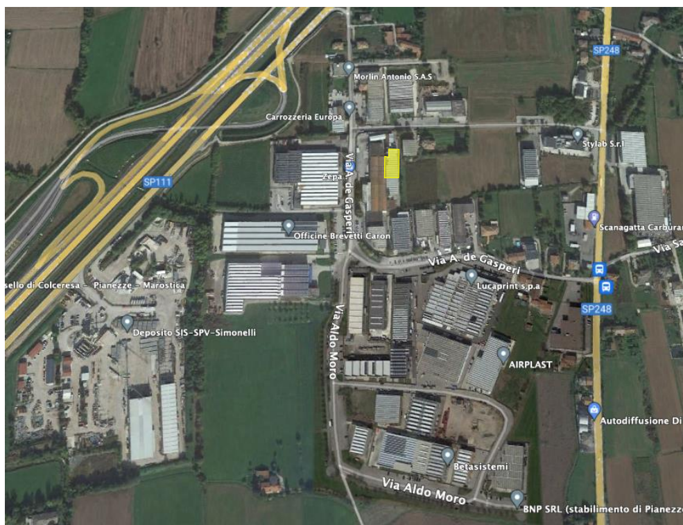
Figura 4. Immagine satellitare (tratta dal sito www.googleearth.com/maps ) con indicazione del sedime di impianto.
