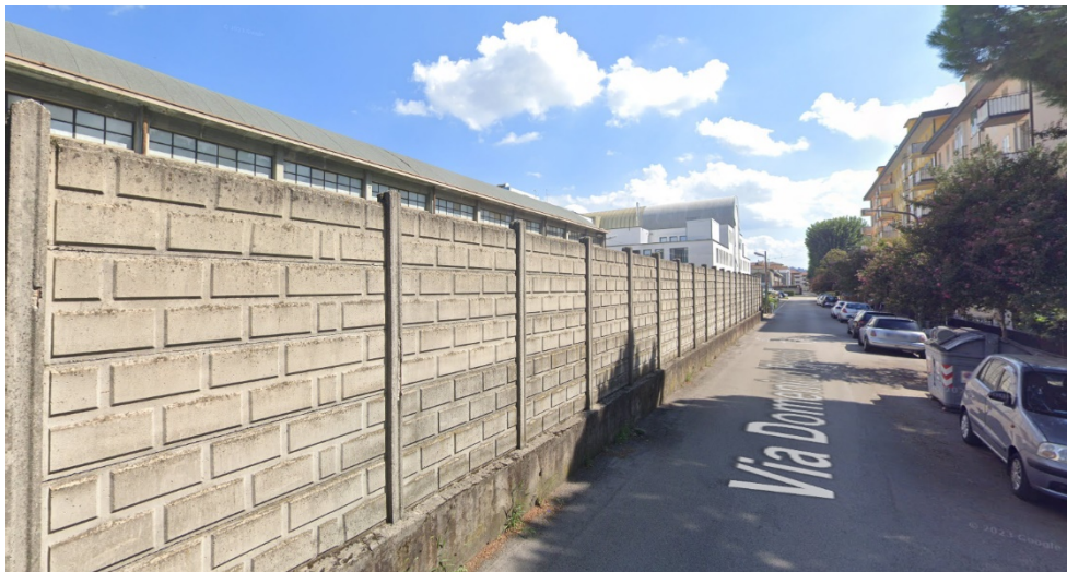
Figura 6-1 – Foto confine lato Ovest dell'area
