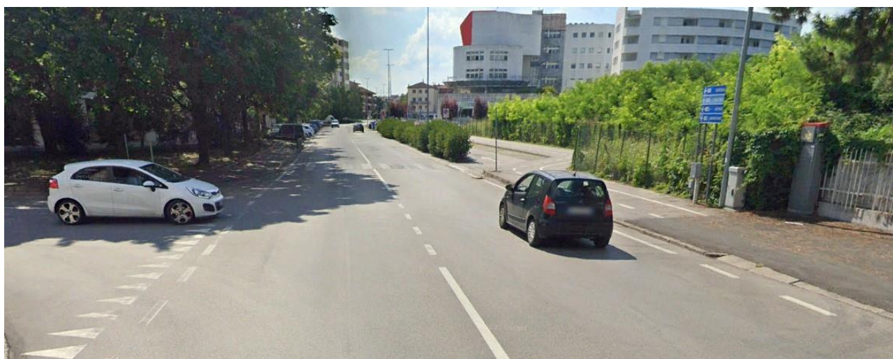
Figura 3.11 – Vista Viale Mercato Nuovo
