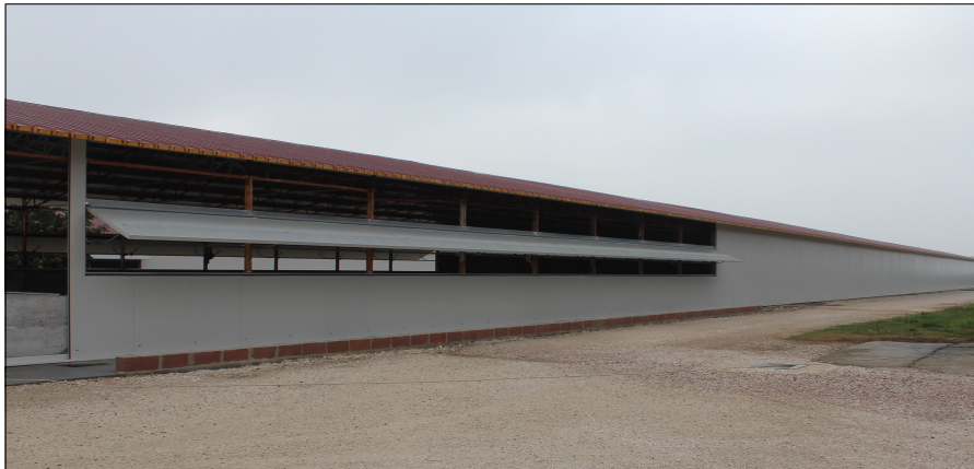
Figura 1: Particolare delle finestre a vasistas, prima del posizionamento del cooling, in un'azienda simile
