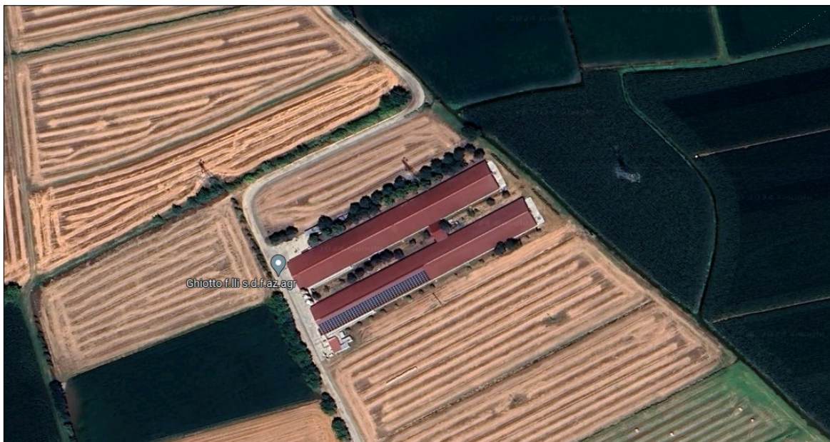
Figura 1: Foto aerea dell'allevamento avicolo esistente
