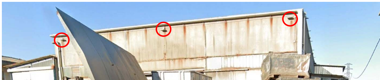
Figura 16: Cono visuale 1, Lato Sud Est dell'installazione
