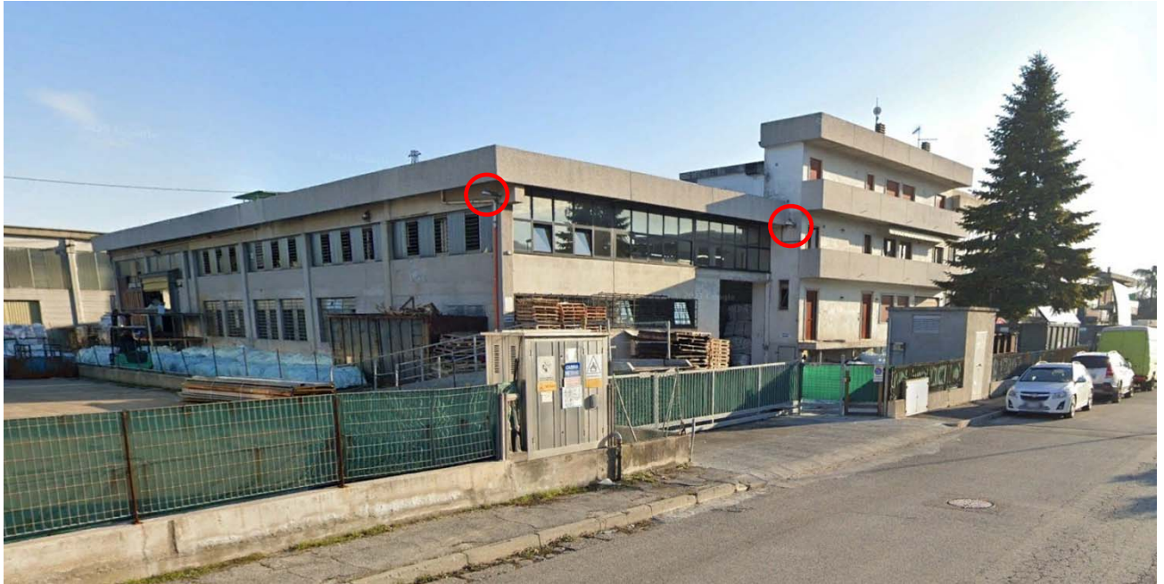
Figura 18: Cono visuale 3, Lato Nord Ovest dell'installazione
