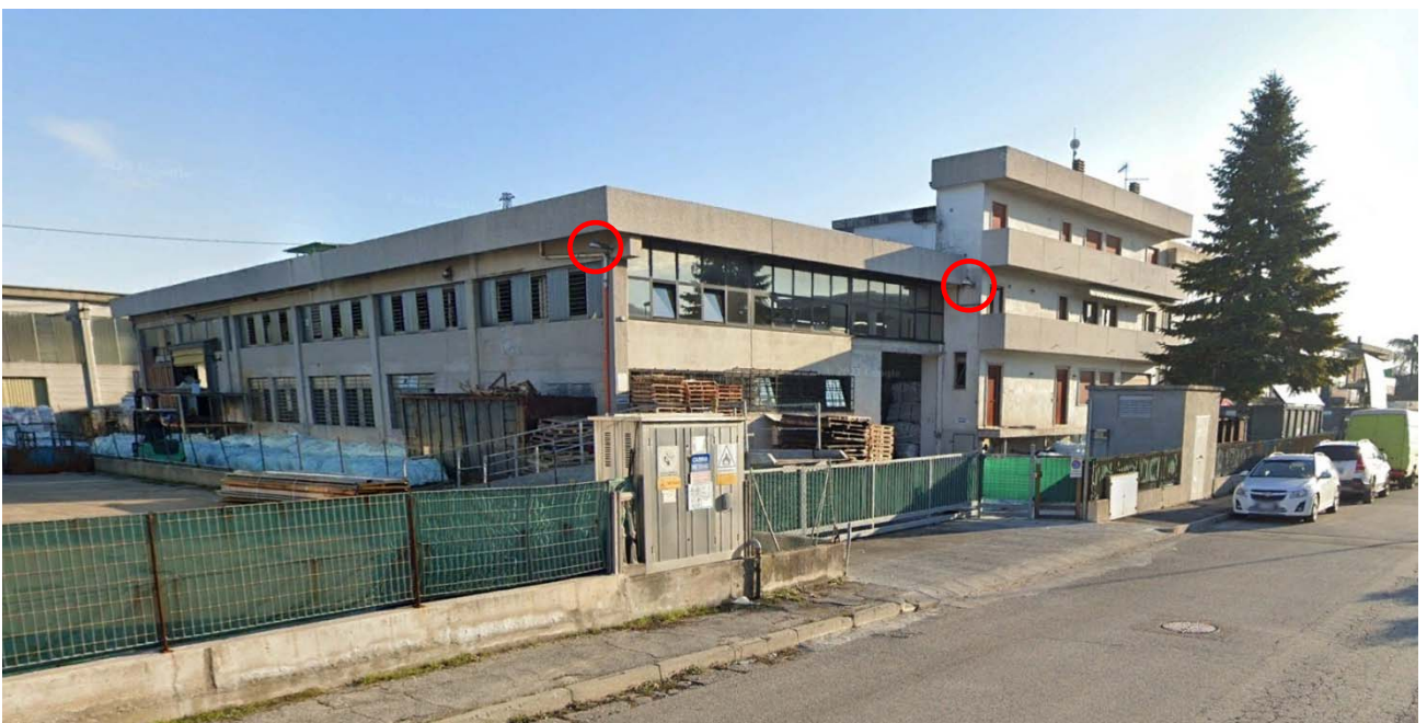
Figura 48: Cono visuale 3, Lato Nord Ovest dell'installazione
