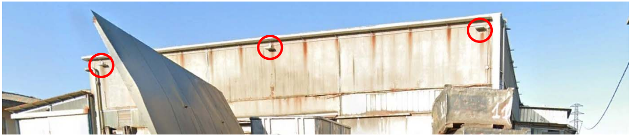
Figura 46: Cono visuale 1, Lato Sud Est dell'installazione
