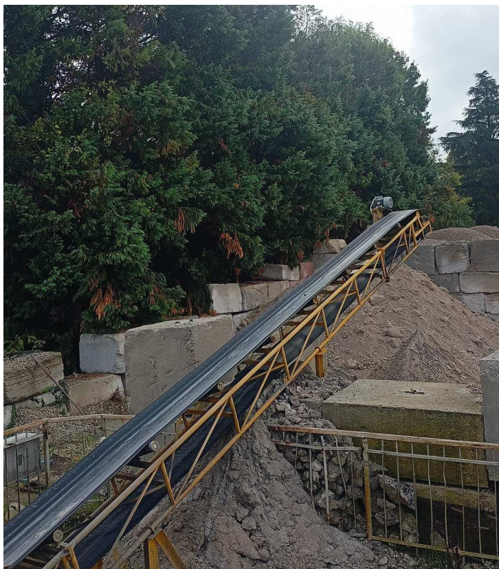
1 - Lato est interno
