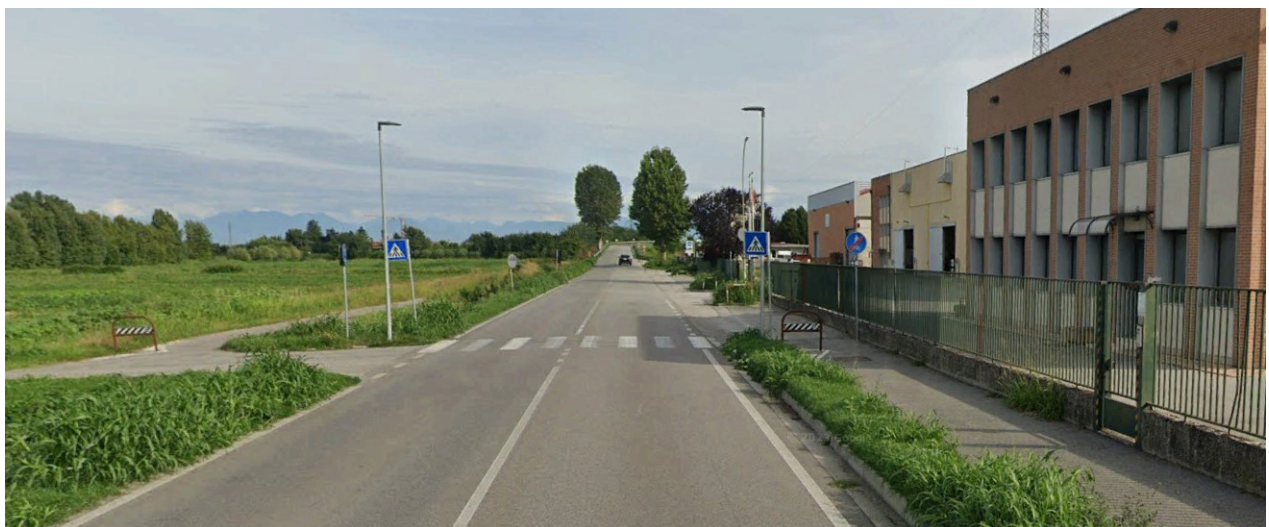
Figura 2.9 Attraversamento ciclo-pedonale su Via Serenissima
