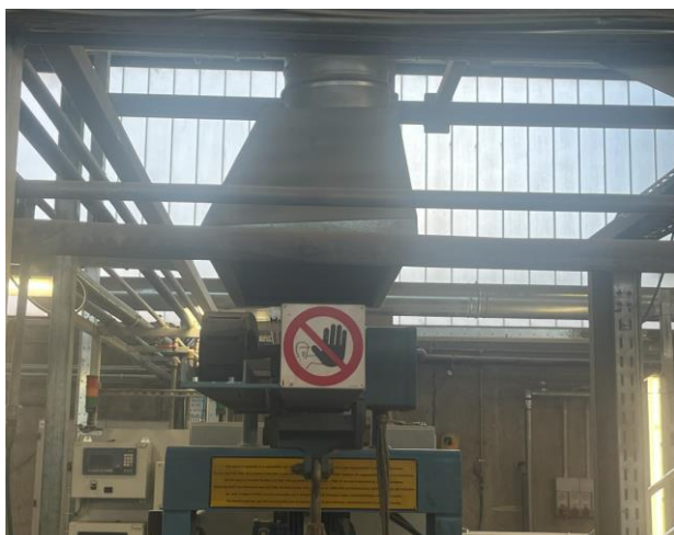
Foto cappa pre-intervento (1000x400)
