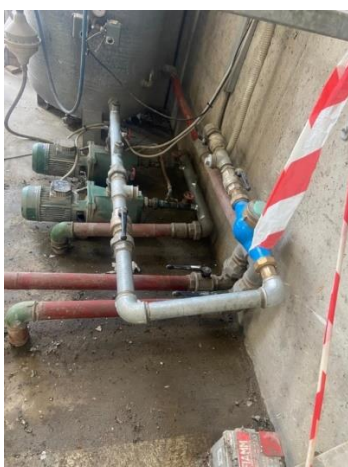
Foto eliminazione bypass
