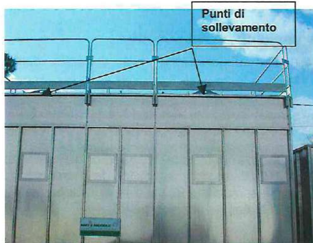
Punti di sollevamento della batteria filtrante e batteria lavaggio
