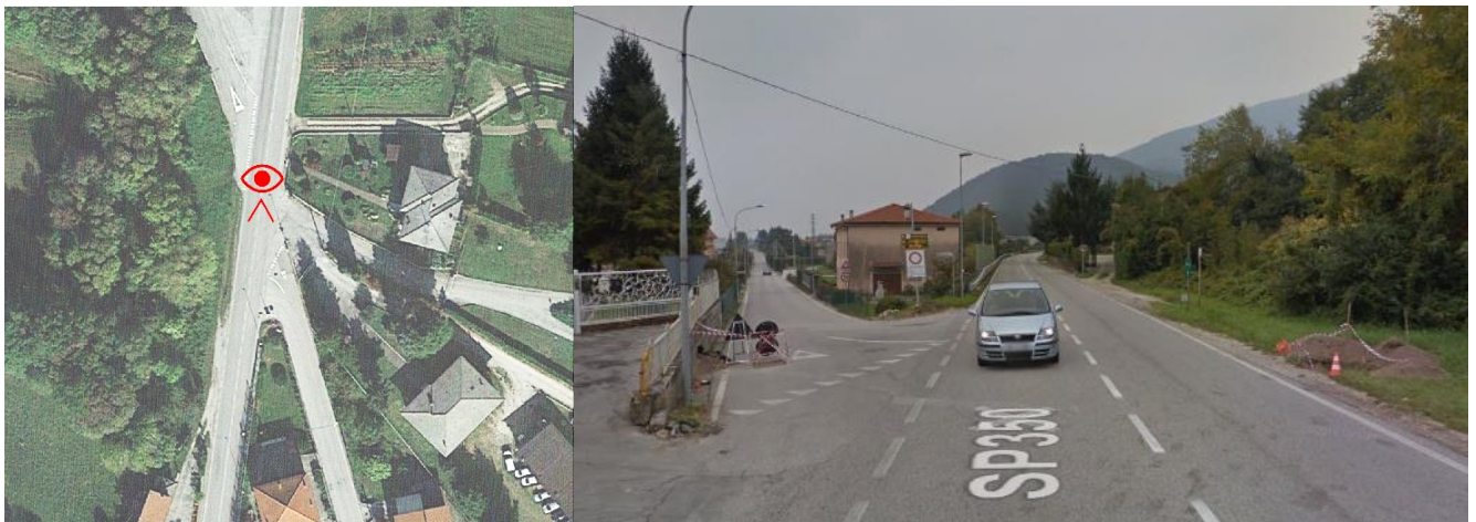
Figura 4.2 - Collocazione del cono ottico di acquisizione dell'elaborato fotografico / Vista frontale dell'intersezione tra la S.P. 350 "Valdastico" (via Marco Polo) e via dell'Industria
