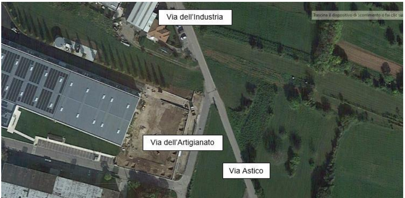
Figura 2.18 - Ortofoto dell'intersezione a raso tra via dell'Artigianato, via Astico e via dell'Industria
