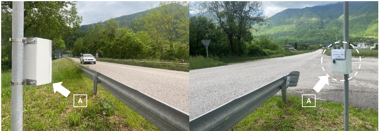
Figura 3.2 - Viste del radar conta veicoli installato nella postazione “A – S.P. 350 “Valdastico” / Via Marco Polo”, foto da sopralluogo in data 08/05/2023
