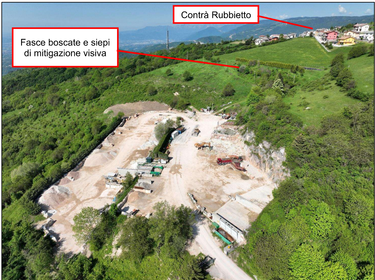
Figura 15: Vista aerea da EST del sito produttivo (rilievo con volo drone)
