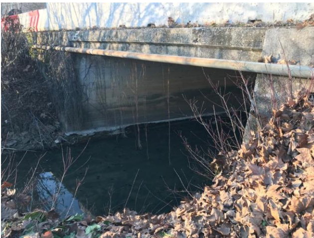
Figura 4: Stato di fatto del ponticello sullo scolo "Cordano" (L=12.00 m).
