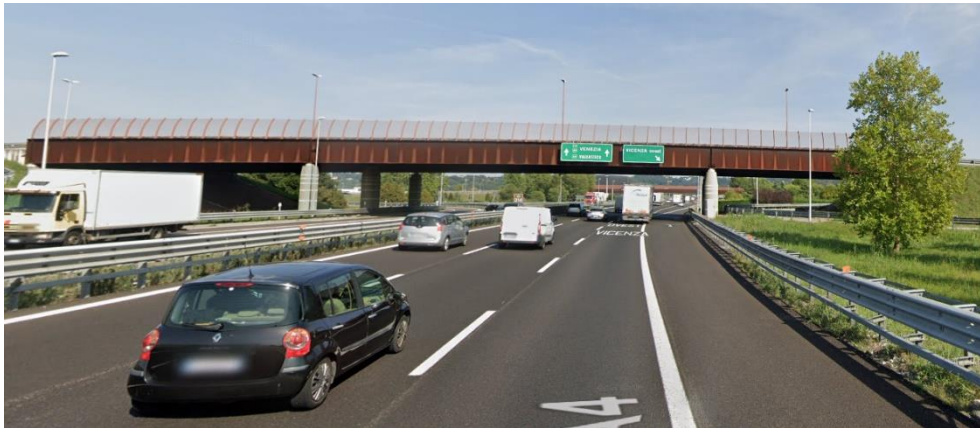
Figura 19 vista del primo cavalcavia incontrato nella direzione Torino-Trieste.
