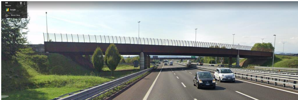
Figura 20 Ponte sul F. Retrone – vista del secondo cavalcavia dalla direzione Trieste-Torino.
