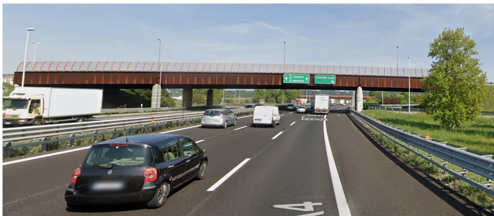
Figura –vista del primo cavalcavia incontrato nella direzione Torino-Trieste
