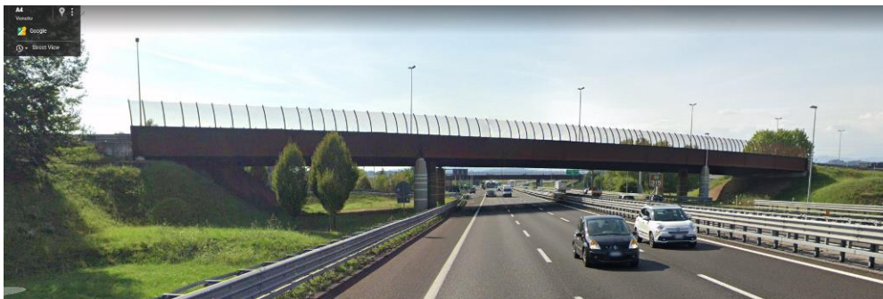
Figura – Ponte sul F.Retrone – vista del secondo cavalcavia dalla direzione Trieste-Torino
