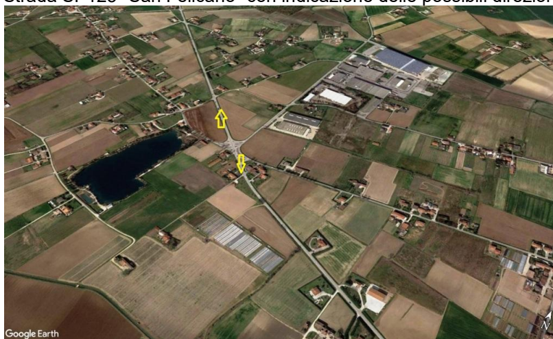
Strada SP125 "San Feliciano" con indicazione delle possibili direzioni
