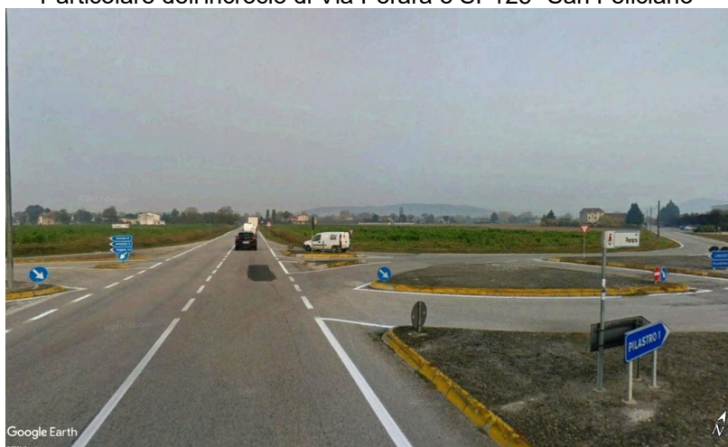
Particolare dell'incrocio di Via Perara e SP125 "San Feliciano"
