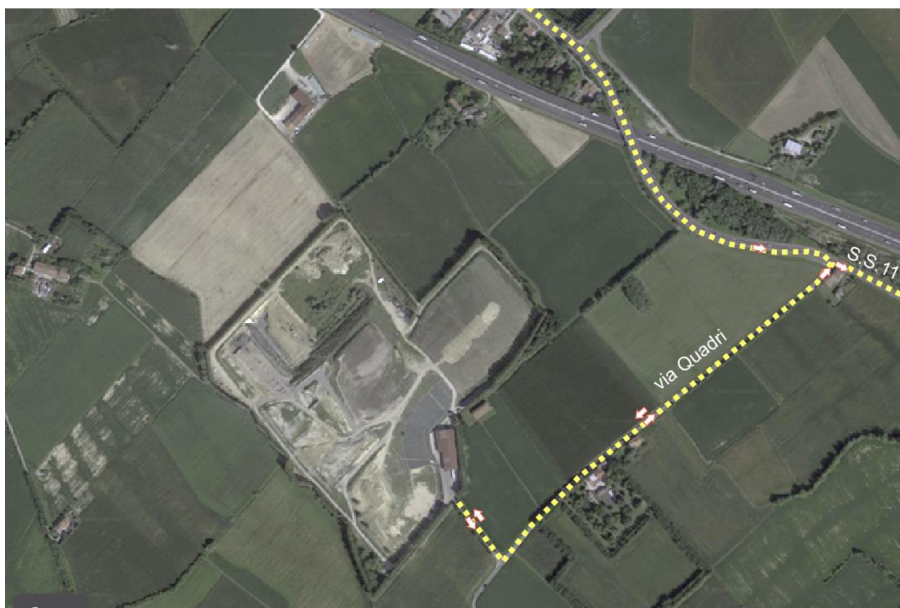
Figura 2 - Foto aerea della Discarica e viabilità di accesso (retino giallo)
