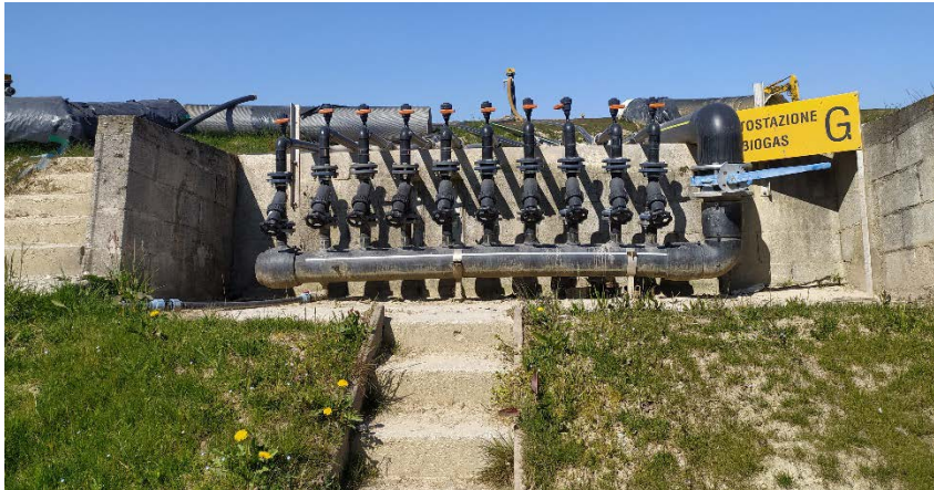
Sottostazioni di raccolta del biogas
