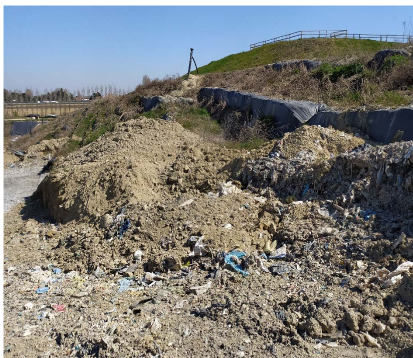
Copertura dei rifiuti mediante materiali inerti
