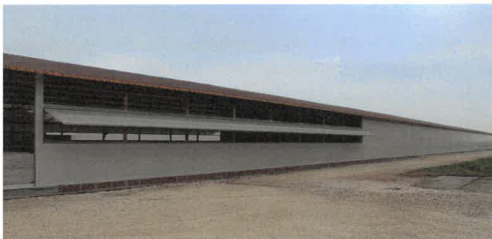
Figura 2: Particolare delle finestre a vasistas, prima del posizionamento del cooling, in un'azienda simile
