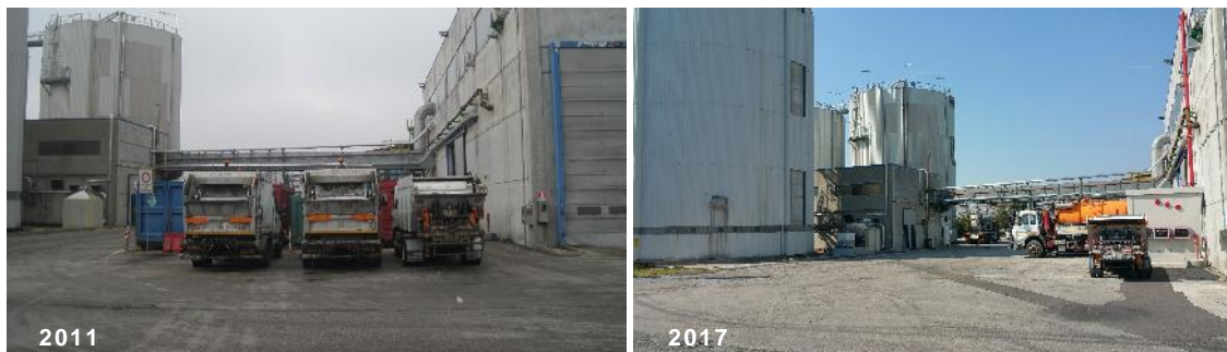
Figura 2: Edificio di selezione (a destra in ciascuna foto) e digestori con interposto edificio di metanizzazione (a sinistra in ciascuna foto).
