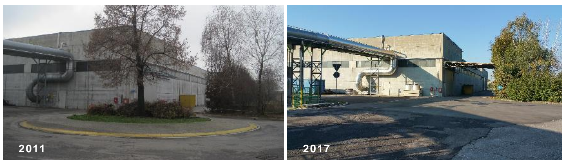
Figura 4: Edificio di compostaggio.
