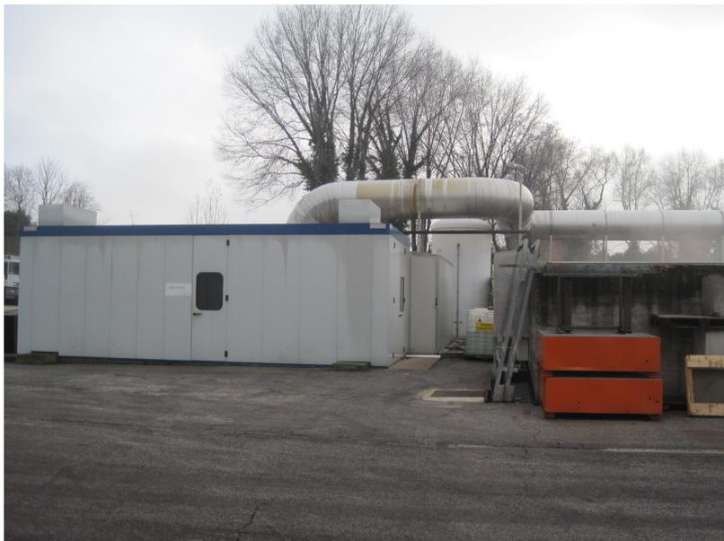
**Figura 3-6: Sistema di trattamento arie mediante scrubber e biofiltro.**
