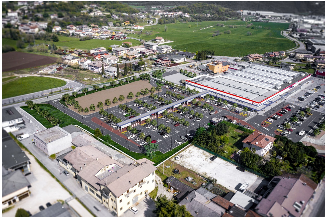
Vista aerea dall'angolo Ovest – sotto: Vista dall'angolo Nord-est
