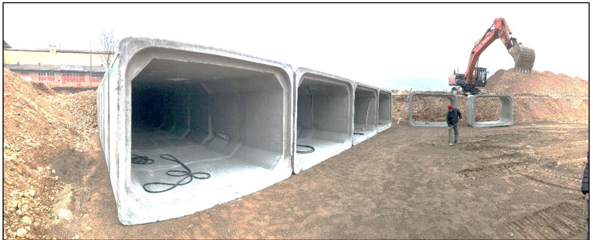
Lavori di posa degli elementi prefabbricati metri 3x2x2
