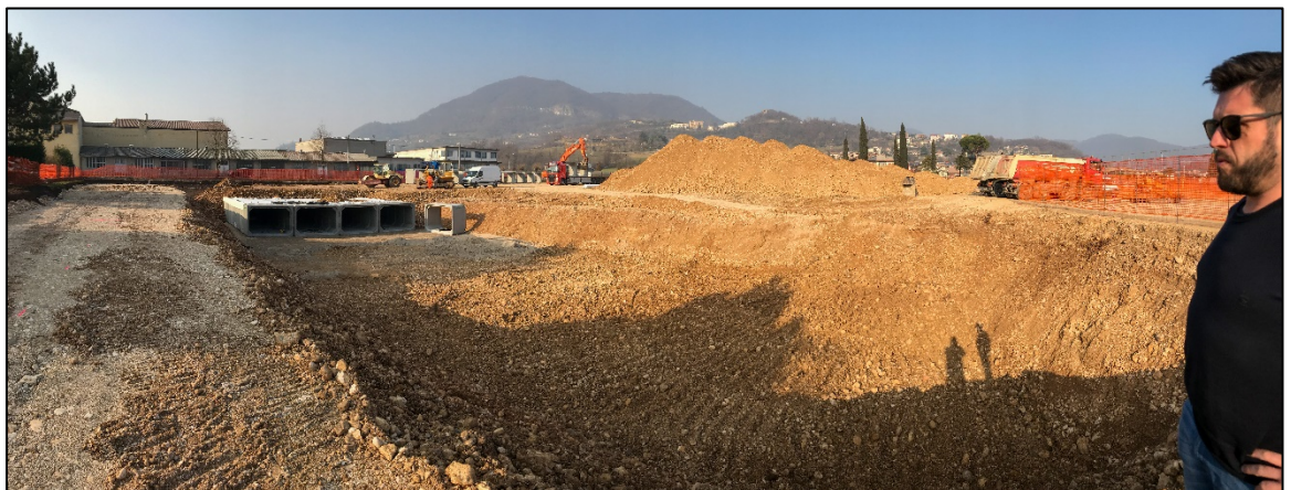
Il bacino ha una larghezza di circa metri 14 ed una lunghezza di metri 67,50
