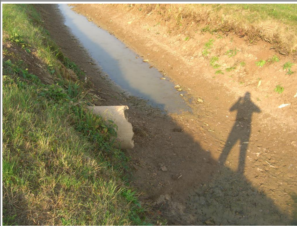
Foto 7. La tubazione esistente di scarico tra lo scolo privato e lo Scolo Pegoraro.
