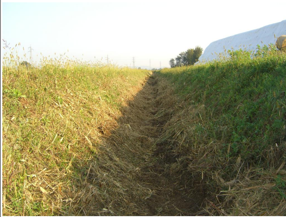
Foto 3. Lo scolo privato dove si prevede lo scarico dal bacino di laminazione.
