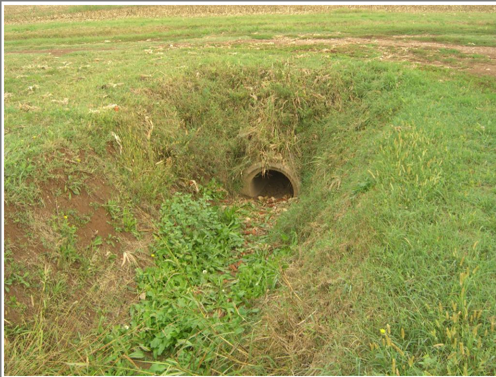
Foto 6. La tubazione esistente di collegamento tra lo scolo privato e lo Scolo Pegoraro.
