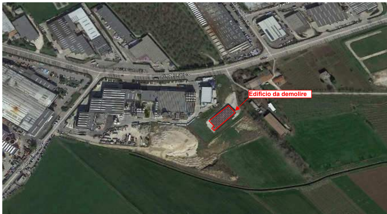
Figura 7 - Edificio da demolire
