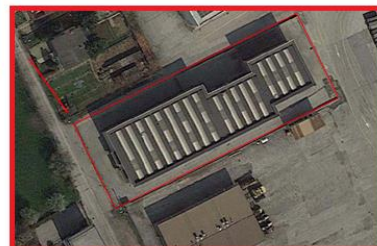
Figura 4: stabilimento oggetto di analisi, visualizzazione di dettaglio
