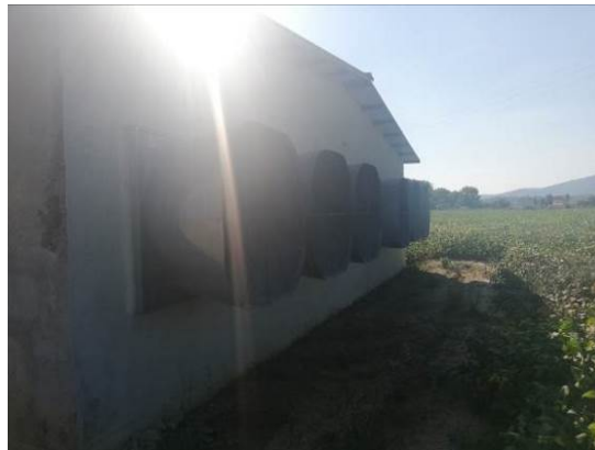
Foto n.2 : ventilatori dei capannoni allo stato attuale
