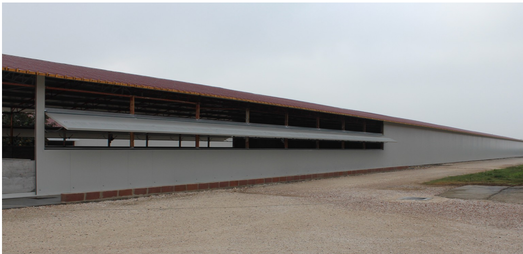
Particolare delle finestre a vasistas, prima del posizionamento del cooling, in un'azienda simile
