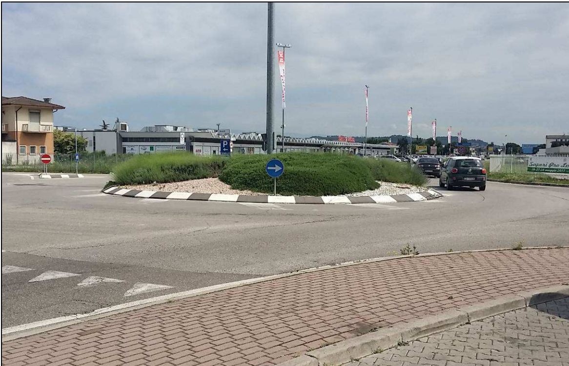
Figura 15 – Intersezione 4 tra viale Trieste, via Bruschi e via Astichello
