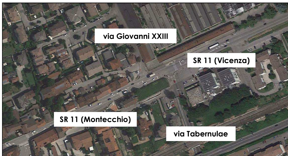
Figura 35 – Vista aerea intersezione fra SR 11, via Tabernulae e via Giovanni XXIII
