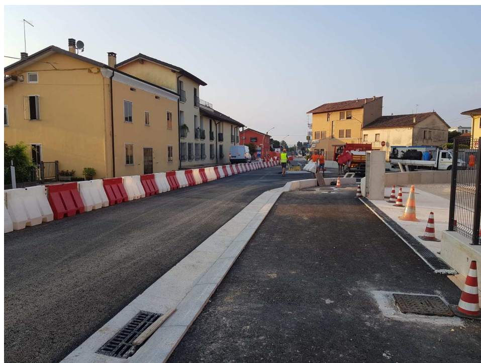
Lavori in corso intersezione "Botteghino"
