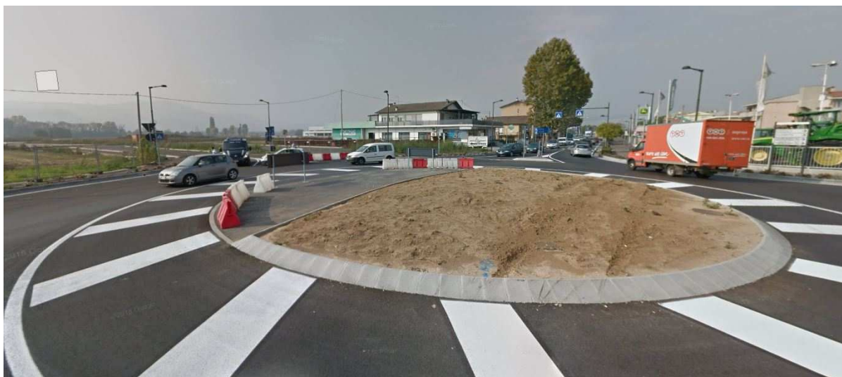
Lavori conclusi intersezione SP 46 - Via De Gasperi – viabilità di lottizzazione
