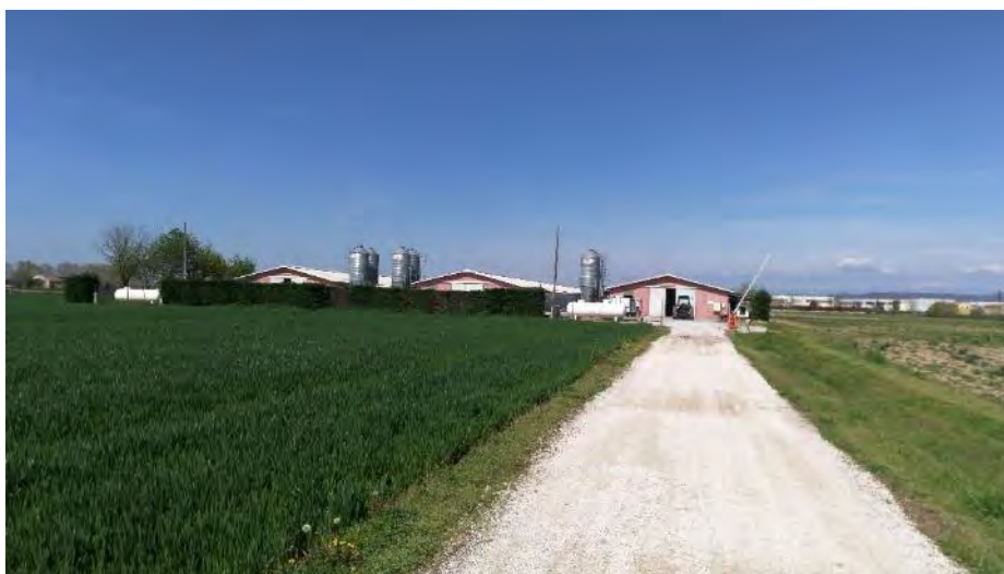
Veduta della dell'attuale configurazione dell'allevamento (n.3 capannoni)
