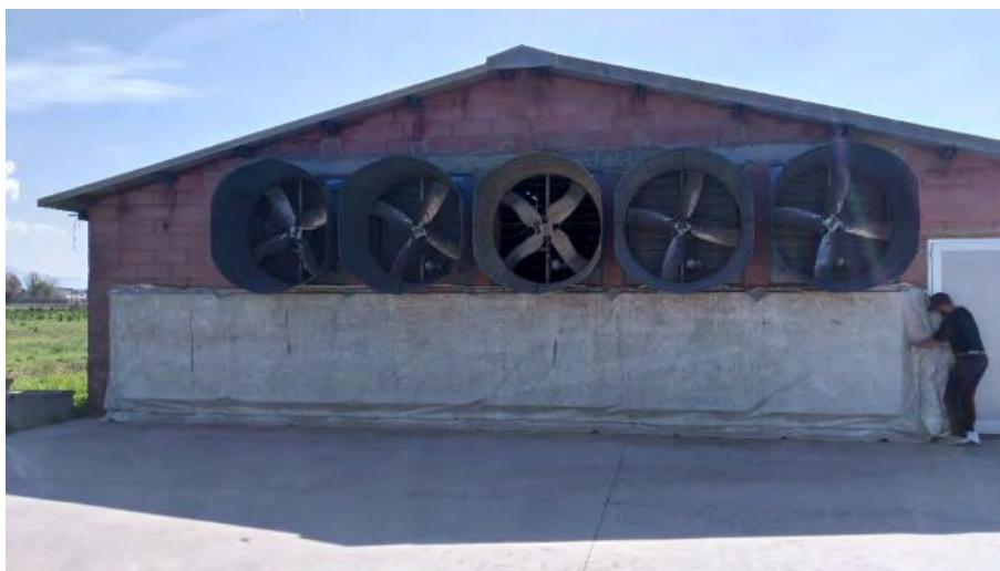
Ventilatori a servizio dei capannoni di allevamento – si noti la chiusura dei 6 ventilatori inferiori disattivati nel periodo invernale
