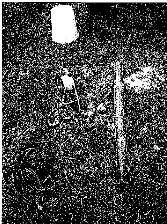
Foto 2: Introduzione tubo e misura falda in S1
