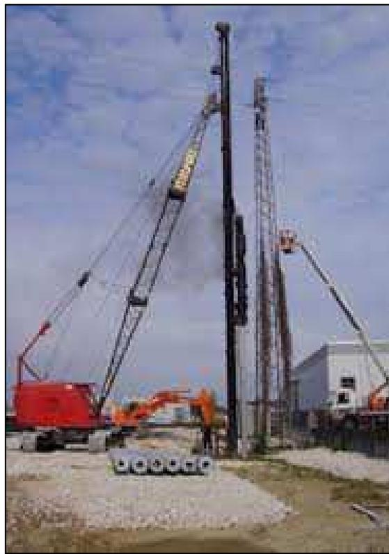
L'infissione nel terreno dei pali prefabbricati si ottiene usualmente con battipalo dotato di maglio diesel, o in alcune applicazioni particolari con maglio a caduta libera; le dimensioni del maglio (peso della mazza ed energia sviluppata) vengono scelte adeguandole alle dimensioni e alle prestazioni del palo da infiggere.
