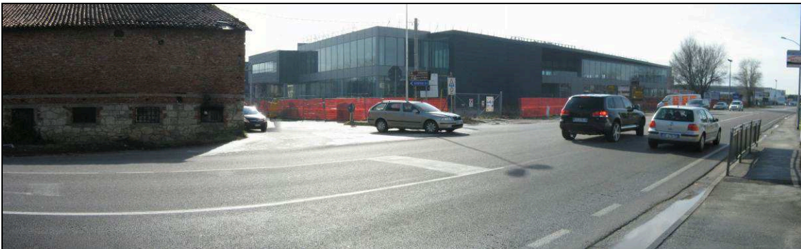
Figura 25 – panoramica intersezione tra SR 11 e via Sottopasso Olmo
