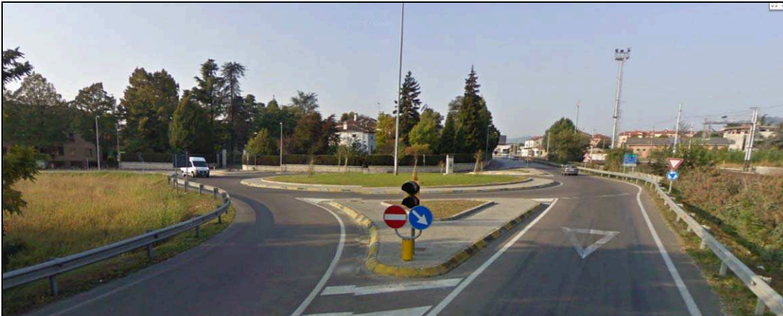
Figura 16 – panoramica intersezione tra SP 34 e via Verdi
