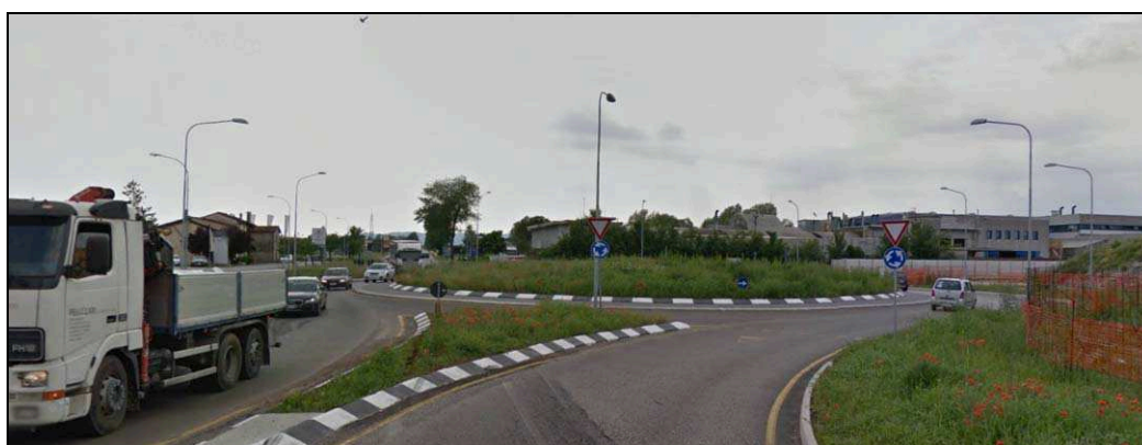
Figura 23 – panoramica intersezione tra SR 11 ed area in esame
