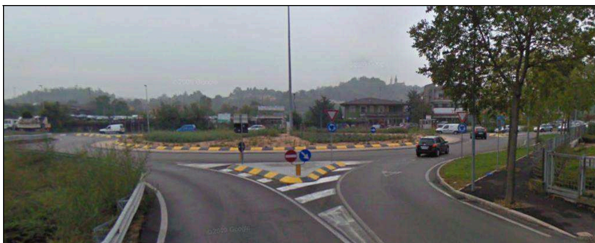
Figura 18 – panoramica intersezione tra SR 11 e via Creazzo
