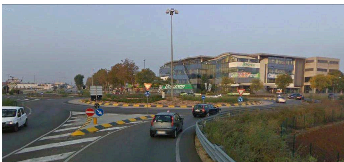
Figura 19 – panoramica intersezione tra SR 11 e via Creazzo
