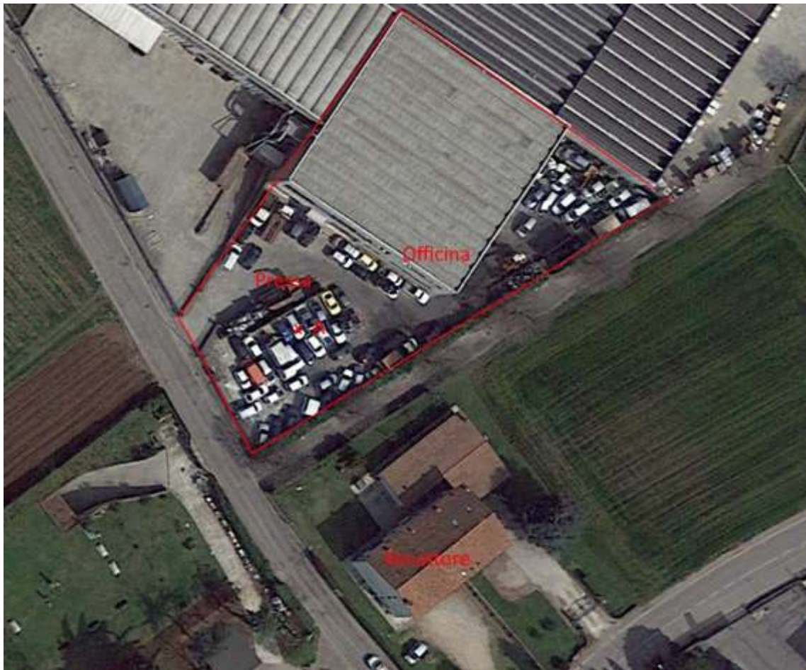
Figura 3: Localizzazione dell'impianto e del recettore sensibile.
