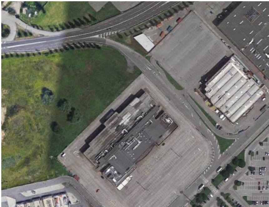
Figura 18 – particolare accesso via Vercelli
