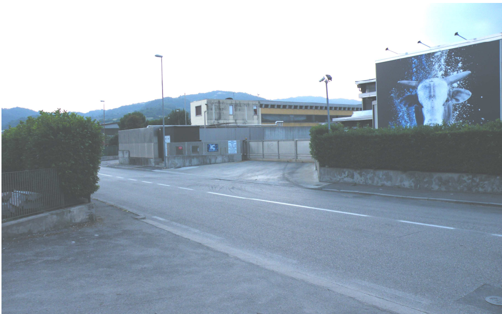
Foto 7: Entrata della committente su via Sesta Strada – direzione ovest
