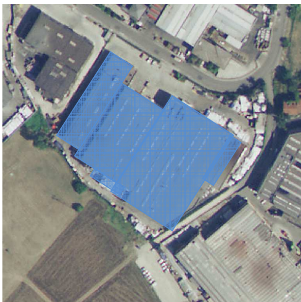
Figura 21 Foto aerea con individuata la copertura
