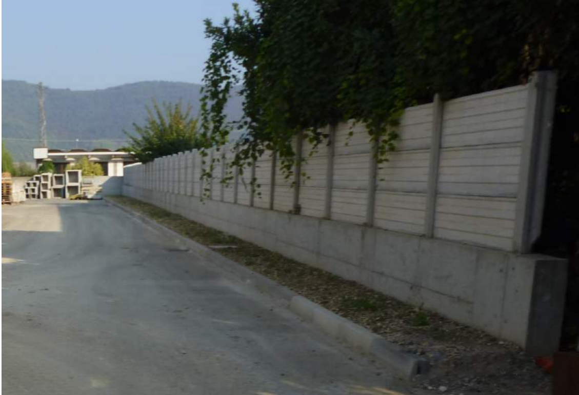
Foto 11- Muro in c.a. lungo il confine aziendale sud-est
