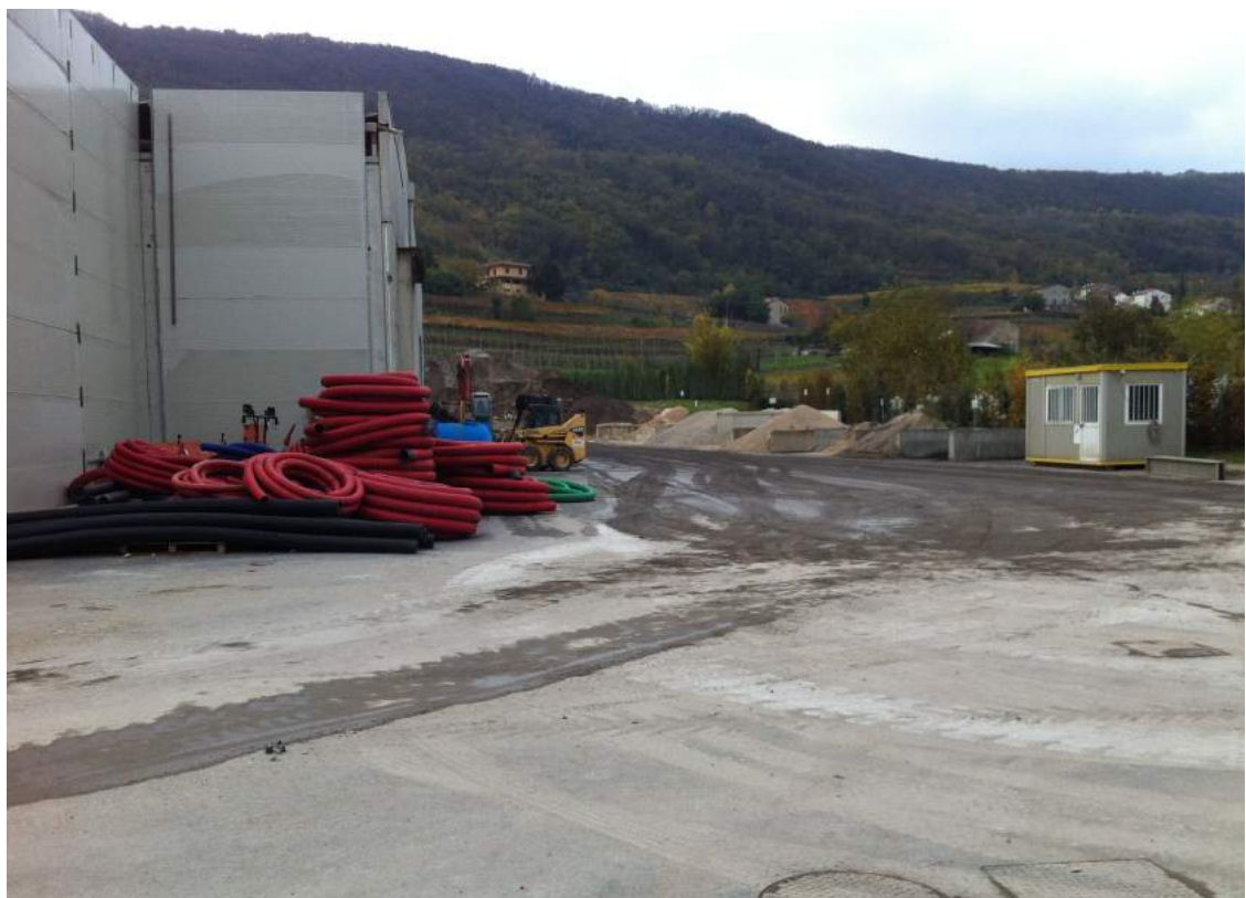
Foto 6 - Vista del piazzale di transito posto a nord del capannone
