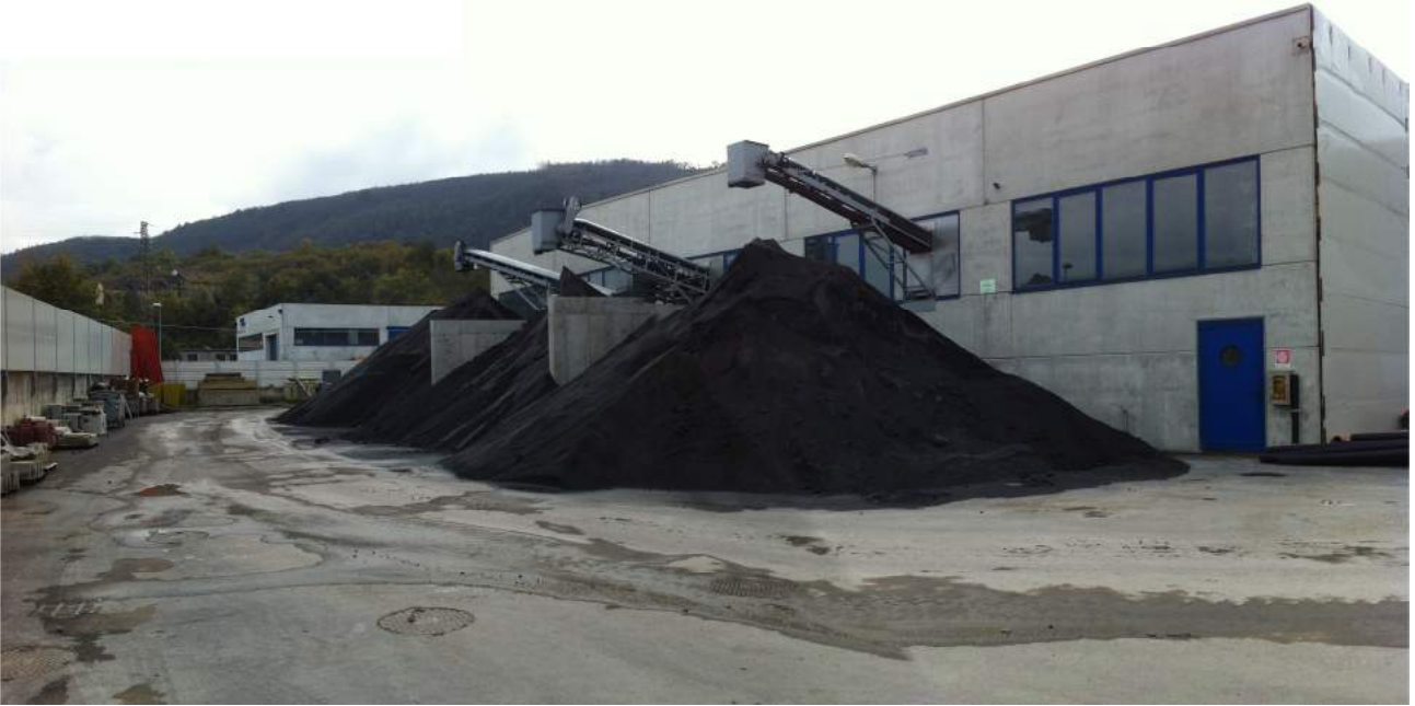
Foto 3 - Vista della facciata est del capannone con i nastri di espulsione scoria trattata (MPS) nelle piazzole S7-S8-S9
