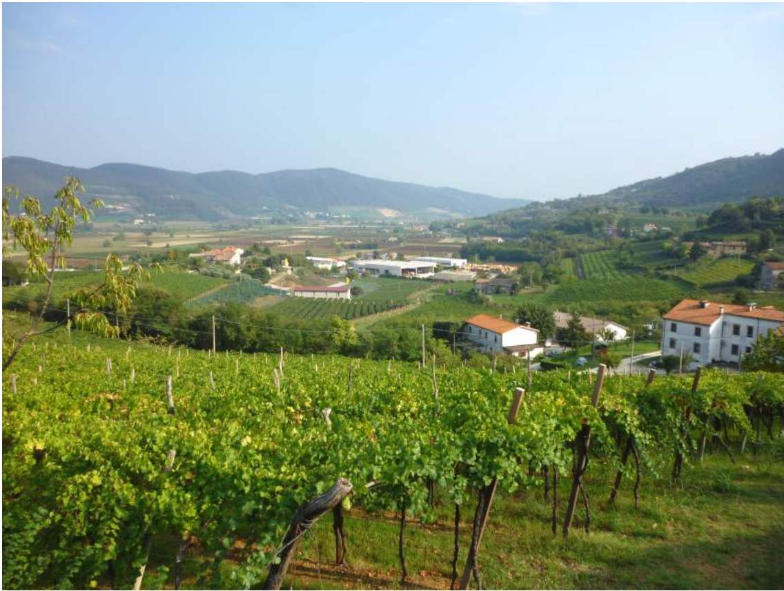
Foto 1- Vista panoramica da nord ovest dell'area dell'impianto
