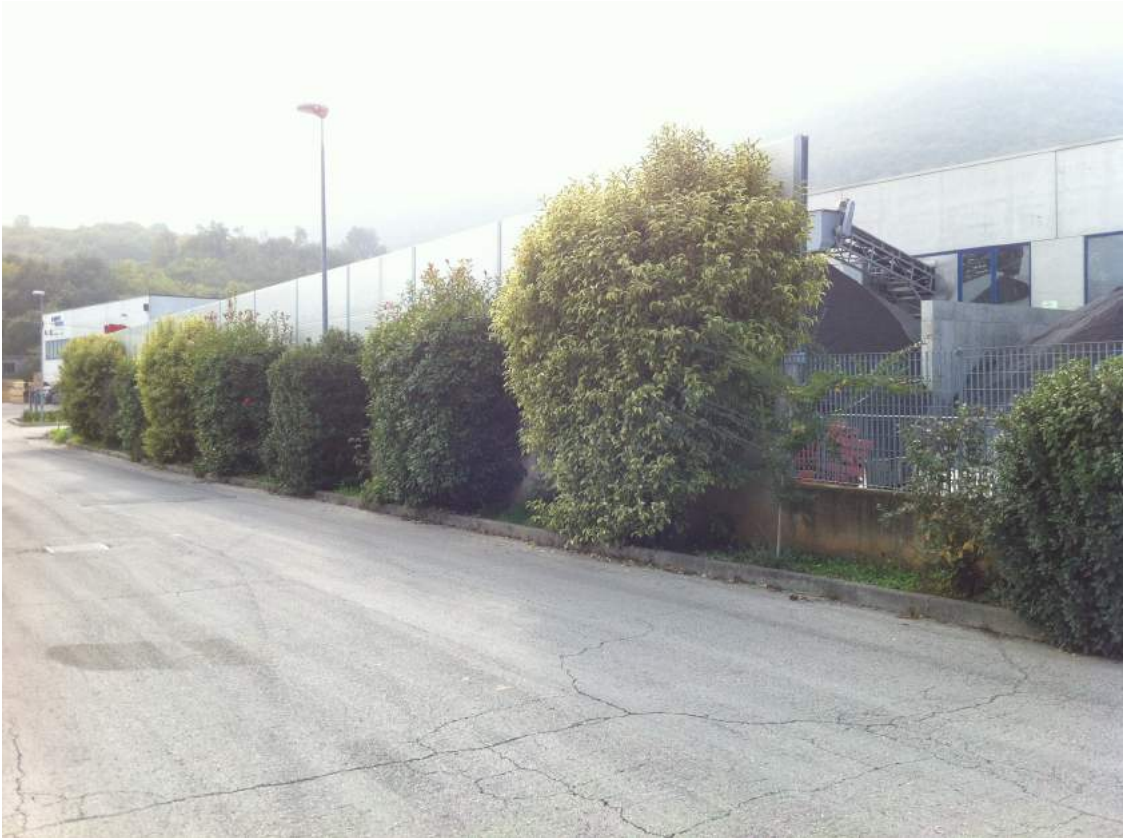
Foto 7 - Vista della barriera acustica e della piantumazione presente al confine est, lungo via Casona
