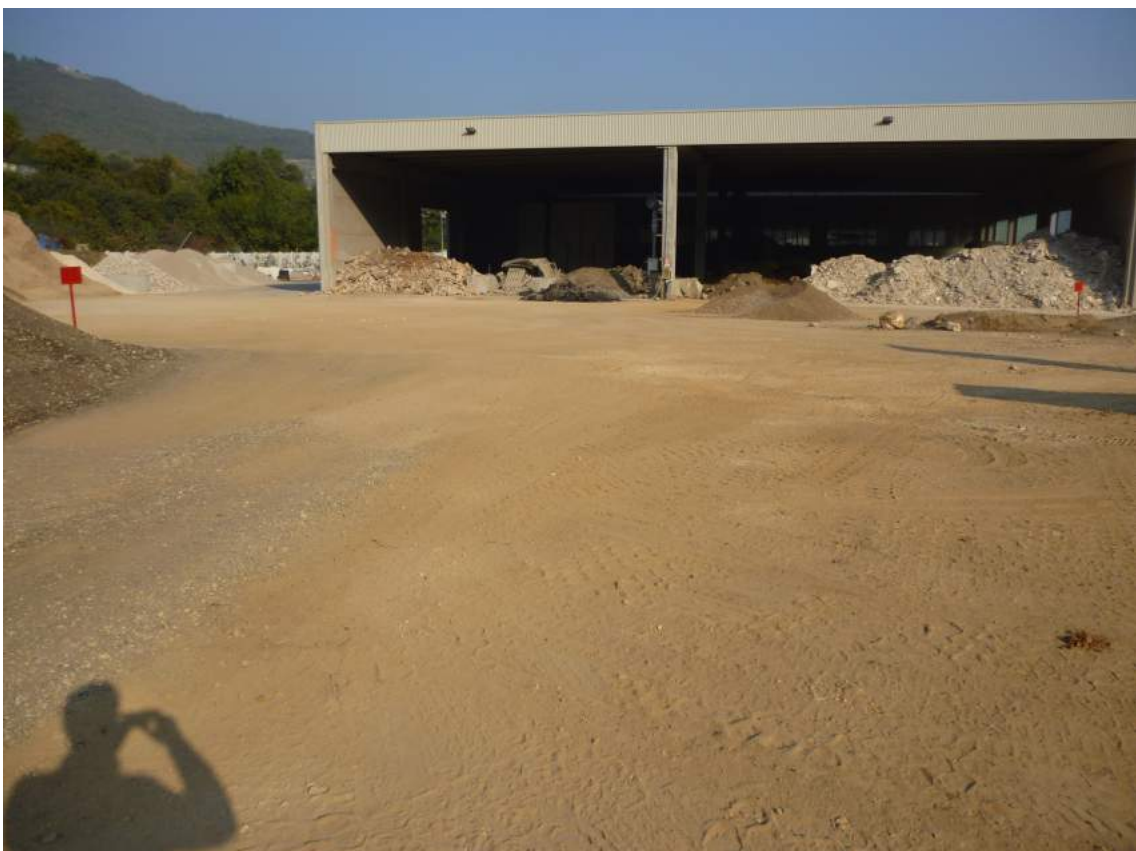
Foto 2- Vista della facciata ovest del capannone e dell'area di Messa in Riserva n°1 dei rifiuti
