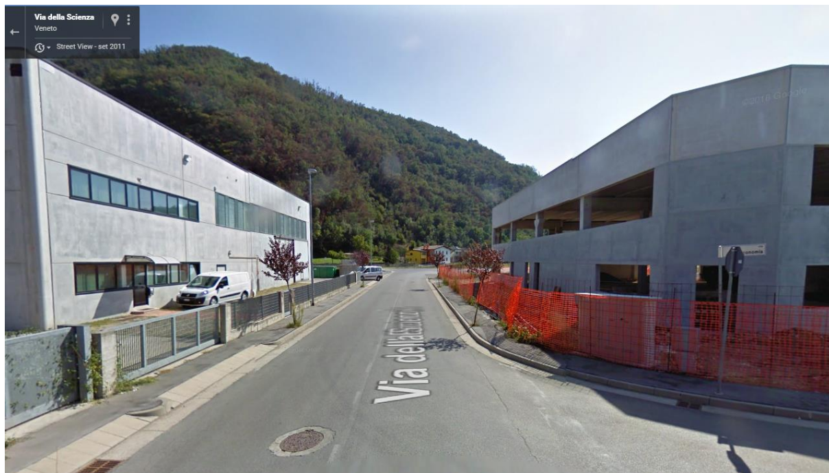
Figura 130 Vista del capannone, direzione Sud Est
