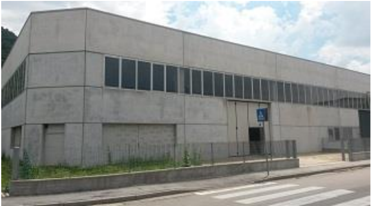
Figura 6 Vista del lato posteriore del capannone
