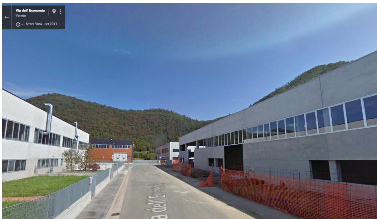
Figura 141 Vista del capannone, direzione Nord Est
