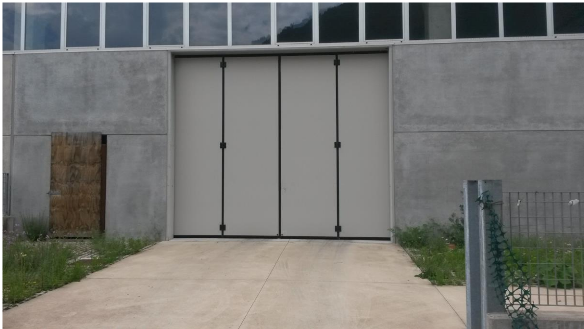
Figura 4 Dettaglio dell'ingresso al capannone
