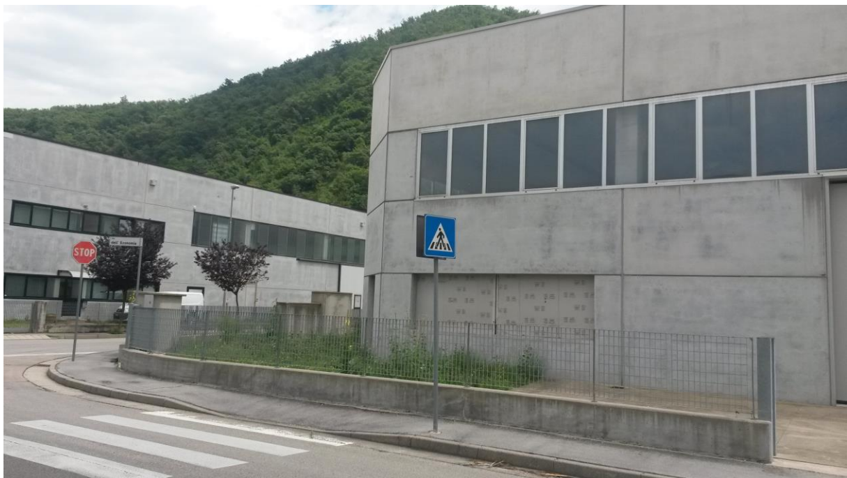
Figura 5 Vista del lato posteriore del capannone, lato Nord Ovest
