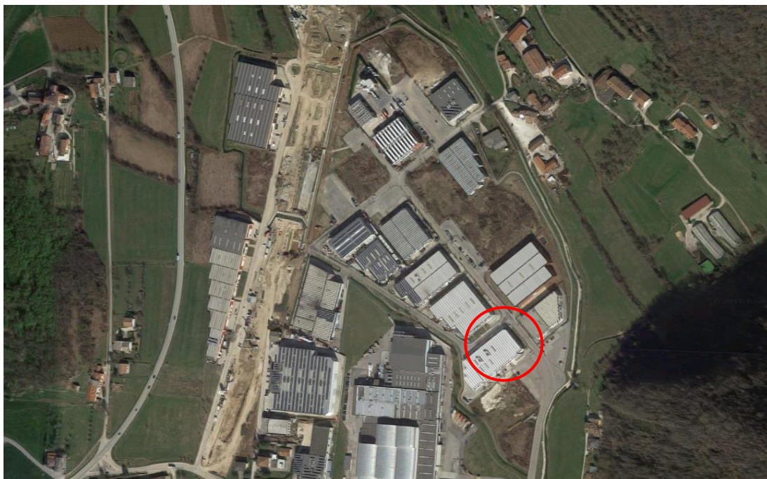
Figura 9 Vista satellitare della zona produttiva
