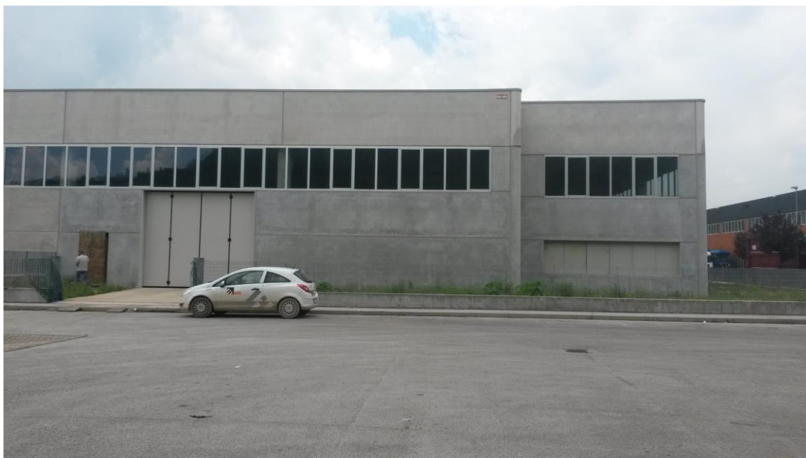
Figura 3 Vista del capannone dal lato dell'ingresso
