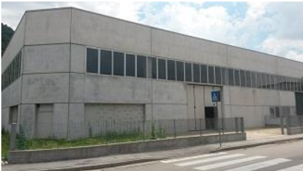
Figura 9: Vista del lato posteriore del capannone
