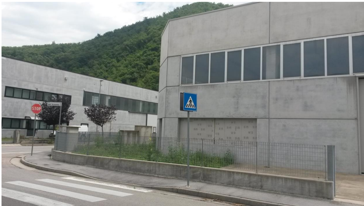
Figura 8: Vista del lato posteriore del capannone
