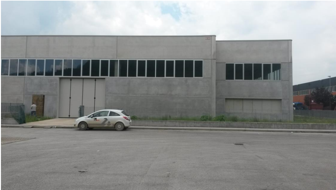
Figura 6: Vista dell'ingresso del capannone
