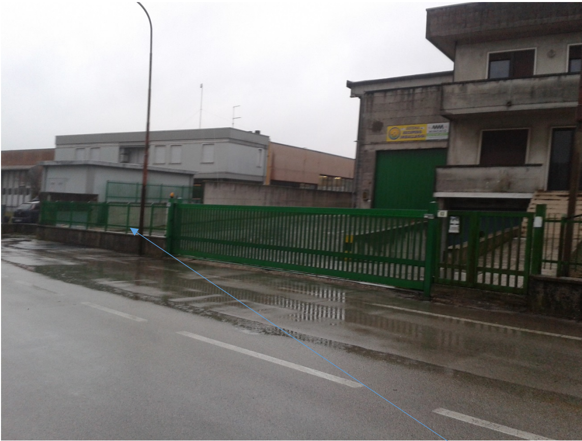
2) Vista dall'esterno e area di deposito MPS di plastica su sacconi muniti di cuffia
