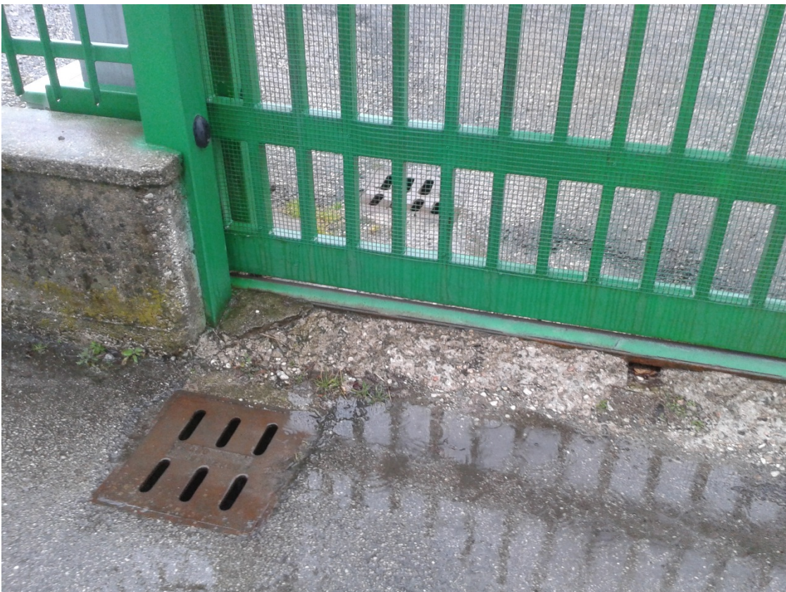
3) Particolare caditoia raccolta acque piovane interno e stradale
