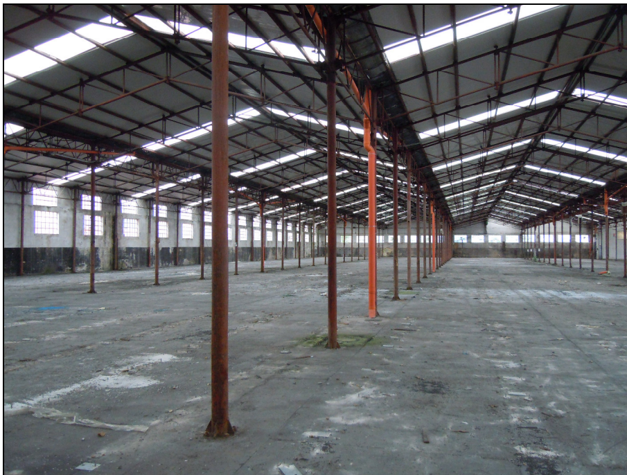
Figura 1: Foto interno capannone sud
