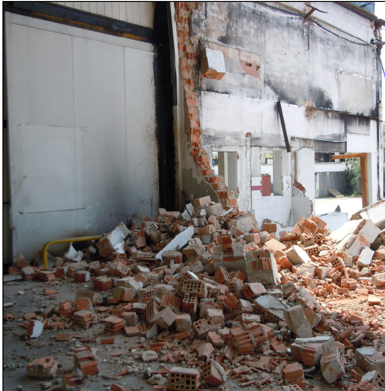
Figura 5: Foto pareti in laterizio
