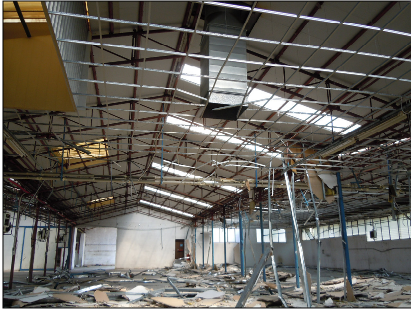
Figura 4: Foto interno capannone nord
